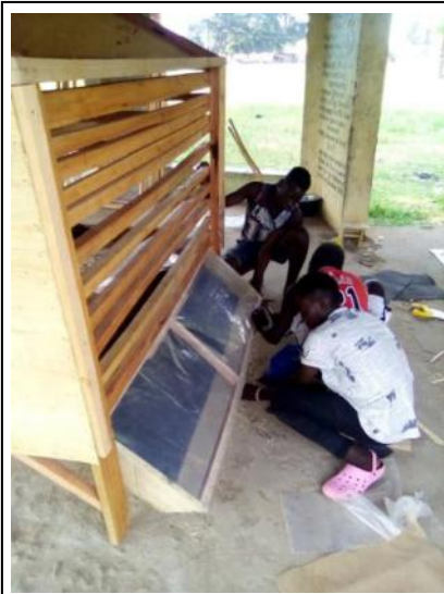
Der große Solartrockner von Gideon Obaikol im Bau
