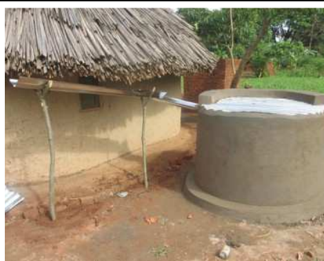
Diese Art Regenwasserbehälter hofft Discover 50 Haushalte im Dorf Kirembe zur Verfügung stellen zu können.
