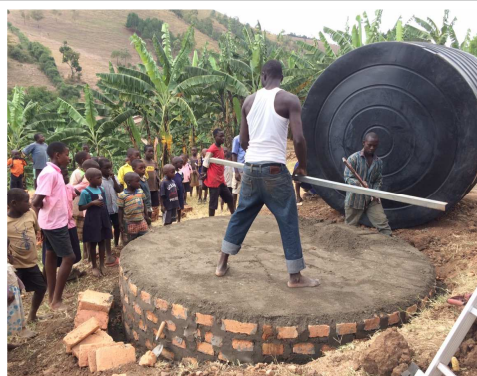
Wir hoffen, zwei dieser viel größeren Regenwasserbehälter im Dorf Nyirivu bauen zu können.
